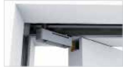
**Einglassener Holzbeschlag** Das Türblatt kann auch trotz komplett abgeschlossener Oberflächenarbeiten nachträglich eingebaut werden, wodurch eine Trennung der Gewerke im Bauablauf möglich ist.
