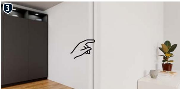
Durch Druck auf die Türkante, wird der Push-Mechanismus aktiviert, der das Türblatt aus der Wand hervor schiebt, sodass der Griff wieder zugänglich ist.
